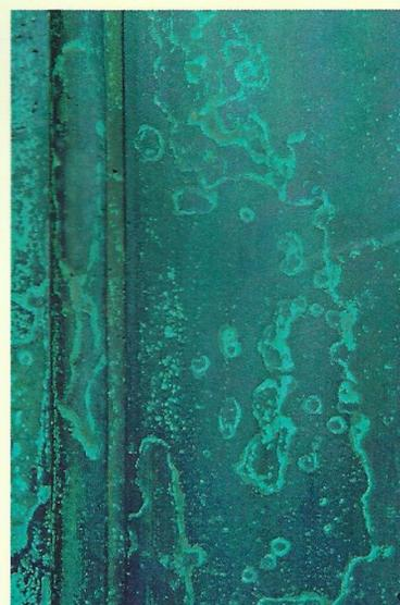
Die dunklen »Inseln« (Abb. 26), die vereinzelt in diesen massiv erodierten Flächen stehen, verdeutlichen das ursprüngliche Oberflächenniveau und den bereits stattgefundenen Verlust von Originalsubstanz.
